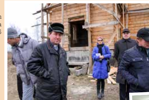
Karatusan kirkon rakennustyömaa Siperiassa v. 2015
