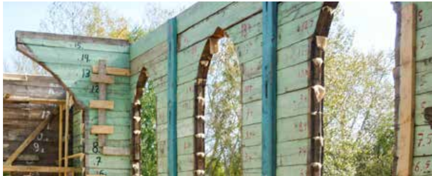
Ala-Bulankan vanhan kirkon hirsikehikko siirrettiin Karatusan kuntakeskukseen ja kunnostettiin. Kuva Vitalij Lutshagov
