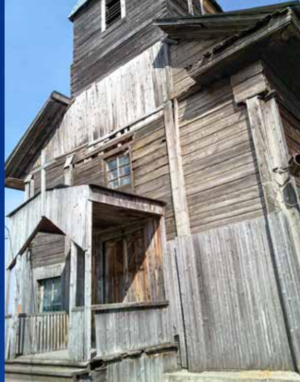
Suetukin kirkko sai noin 15 vuotta siten uuden peltikaton amerikkalaisen avustuksella. Suomalaiset ovat vaihtaneet ulkolaudoituksen, joka on myös saanut maalia pintaansa.
